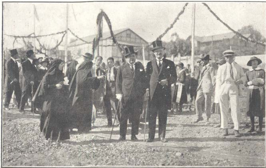
Santa Cruz de Tenerife.-- Vista del solar en que ha de edificarse el Colegio de la Pureza
